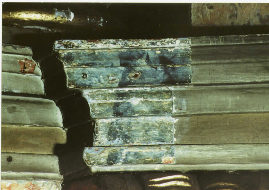
Fragment cokołu w trakcie prac odkrywkowych. W obszarze odsłoniętej oryginalnej marmoryzacji widoczne są nieusunięte jeszcze wtórne kitówki oraz skorodowane główki gwoździ.
