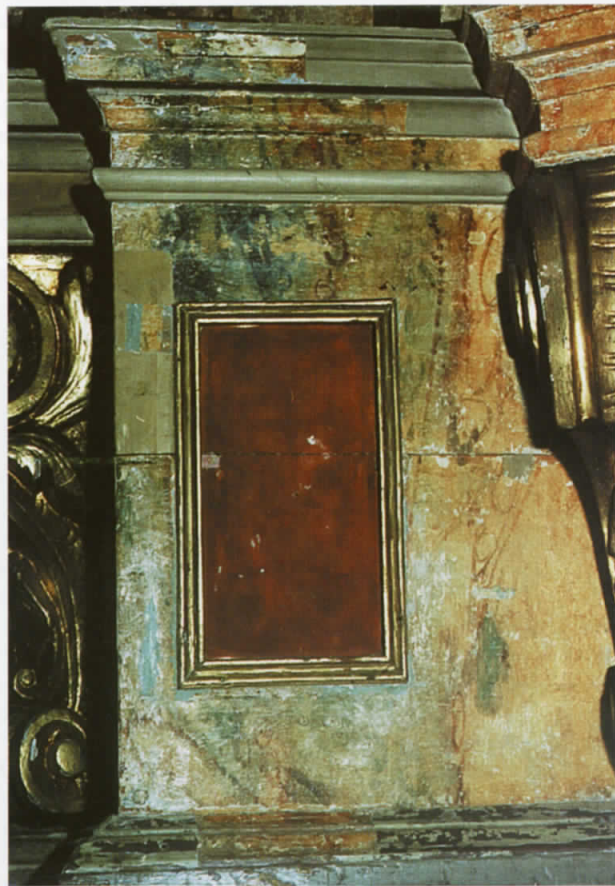
Fragment przedniej ścianki cokołu w trakcie prac odkrywkowych. Widoczna odsłonięta częściowo oryginalna marmoryzacja.
