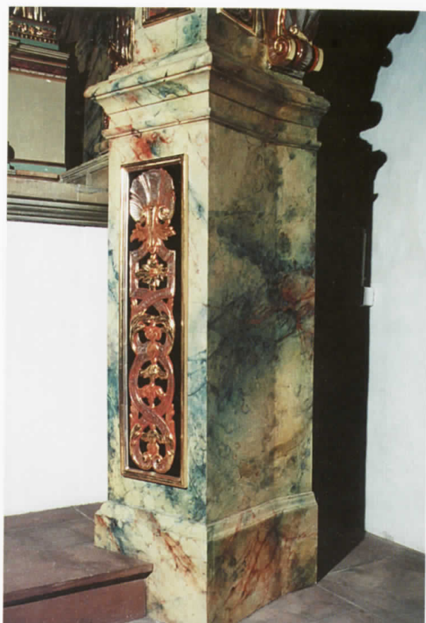
Prawa, przyziemna część cokołu po wypunktowaniu i rekonstrukcji marmoryzacji oraz zamontowaniu snycerskiej dekoracji.
