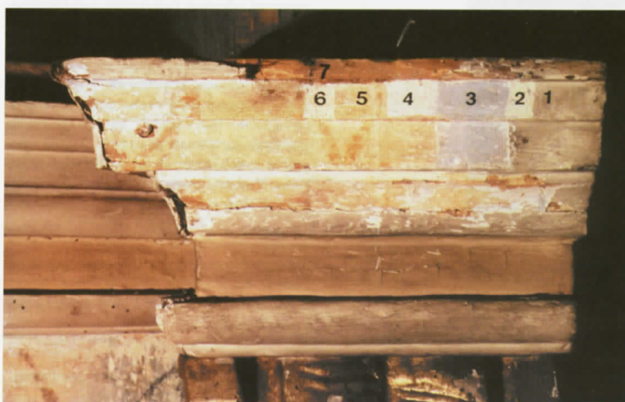
Gzyms cokołu w trakcie prac badawczych oraz prób usuwania wtórnych opracowań. Widoczna odkrywka stratygraficzna z układem warstw (3 opracowania chronologiczne, 7 warstw technologicznych); 1) olejne opracowanie ostatniej renowacji z lat 60-tych XX stulecia, 2) olejny podkład ostatniej renowacji, 3) olejne opracowanie pierwszej renowacji z 1928 r., 4) olejny podkład pierwszej renowacji, 5) oryginalne opracowanie temperowej marmoryzacji z 2. poł. XVIII w., 6) oryginalna zaprawa kredowo-klejowa, 7) drewno.
